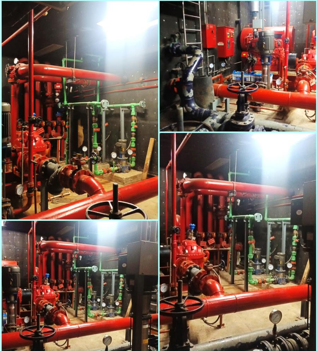
รูปที่ 12.26 ระบบท่อยืน ประกอบด้วย ท่อยืน (Stand Pipe) ขนาดเส้นผ่านศูนย์กลาง - 6 นิ้ว จำนวน 2 ท่อ
