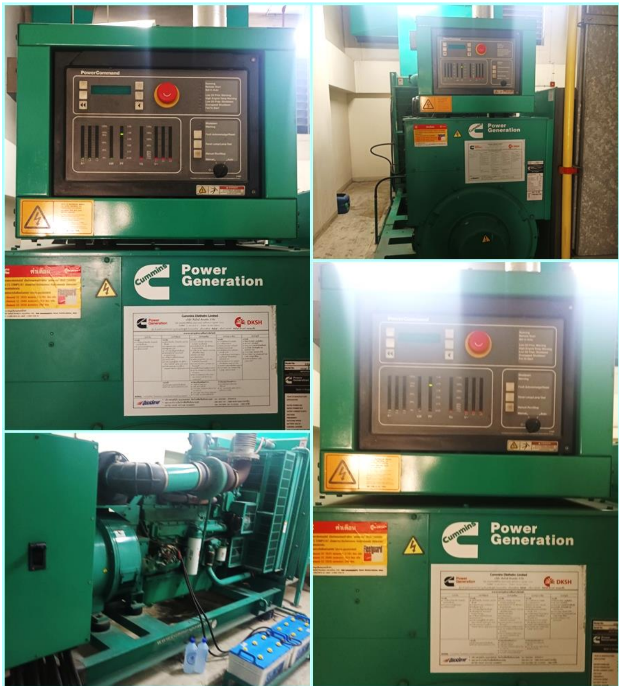
รูปที่ 12.24 เครื่องกำเนิดไฟฟ้าฉุกเฉิน (Generator ขนาด 450 KVA จำนวน 1 ชุด)
