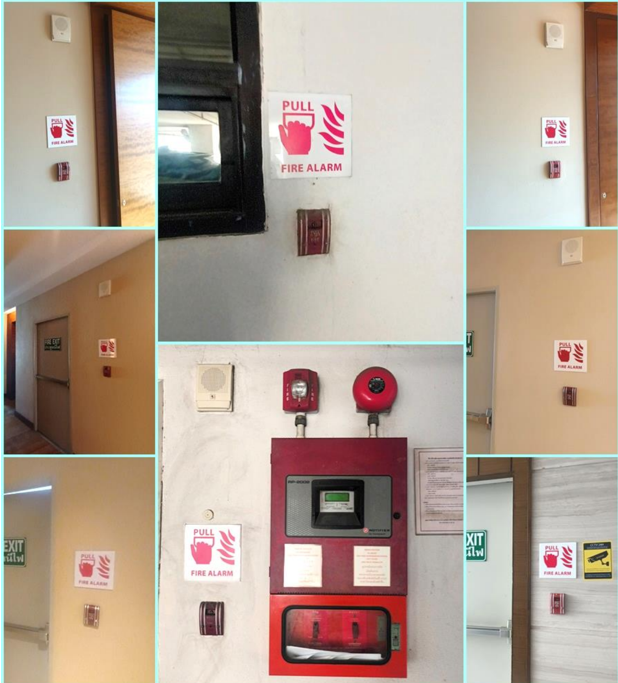
รูปที่ 12.37 เครื่องแจ้งเหตุโดยใช่มือดึง (Fire Alarm Manual Station)
