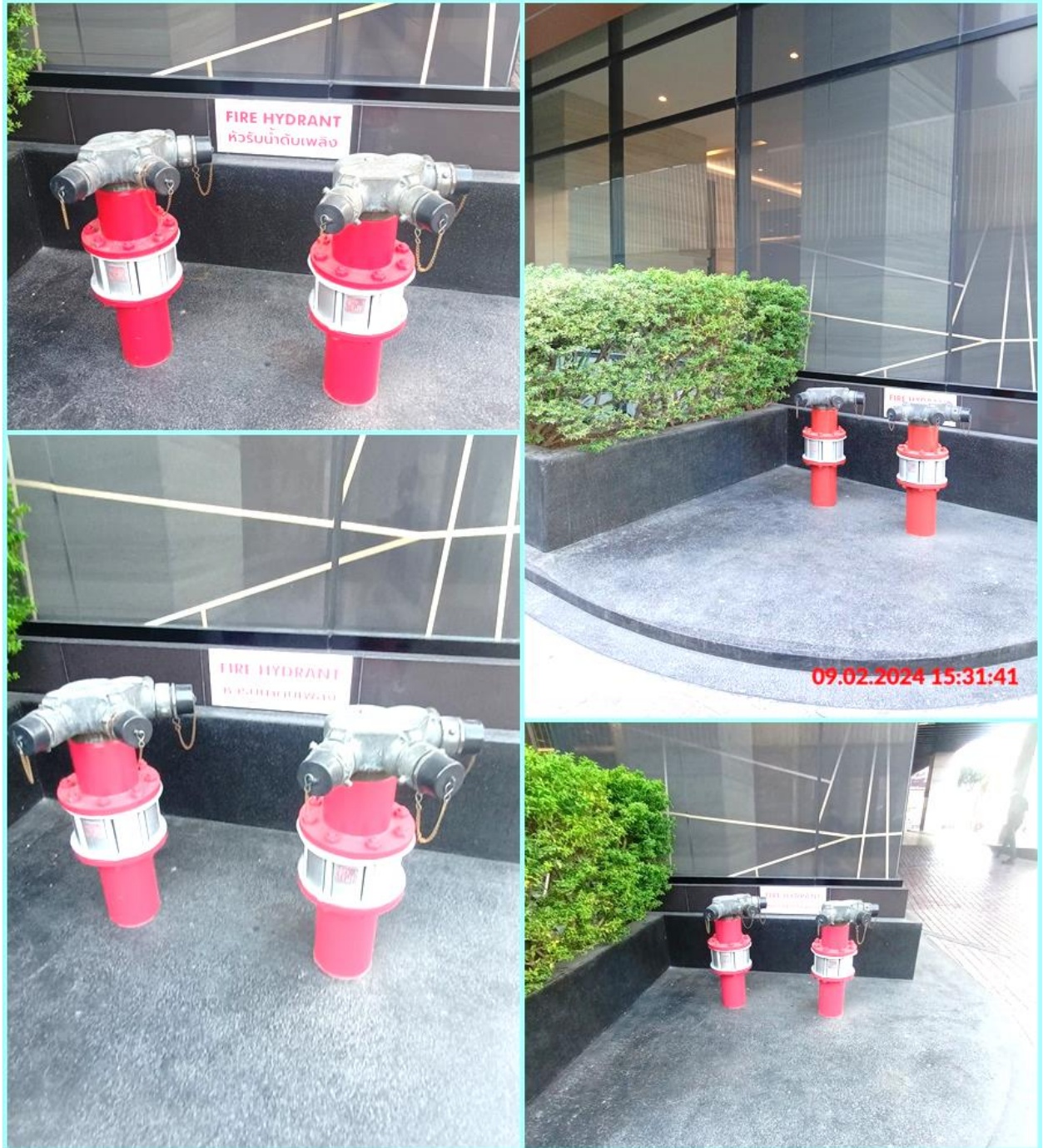
รูปที่ 12.28 หัวรับน้ำดับเพลิงภายนอกอาคาร (Fire Department Connector : FDC)
