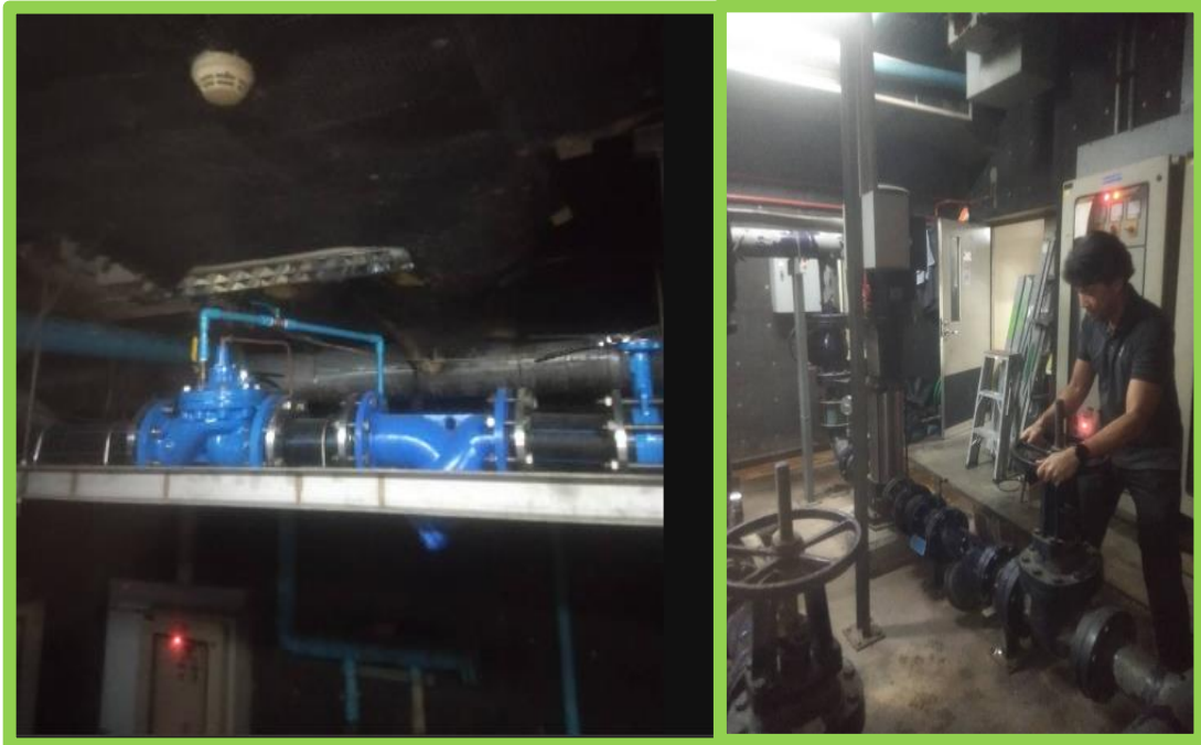
รูปที่ 12.72 ตรวจสอบเส้นท่อตรวจสอบเส้นท่อประปา และการทำงานของเครื่องสูบน้ำและวาล์ว
