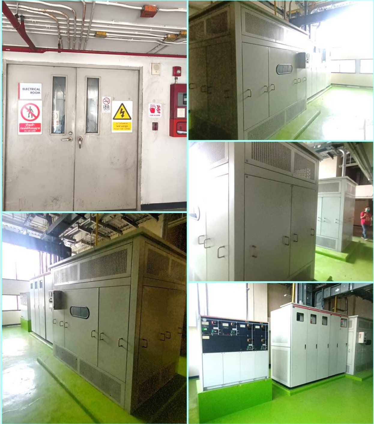
รูปที่ 12.23 หม้อแปลงไฟฟ้าชนิด Dry Type Cast-Resin ขนาด 1,600 KVA จำนวน 2 ชุด
