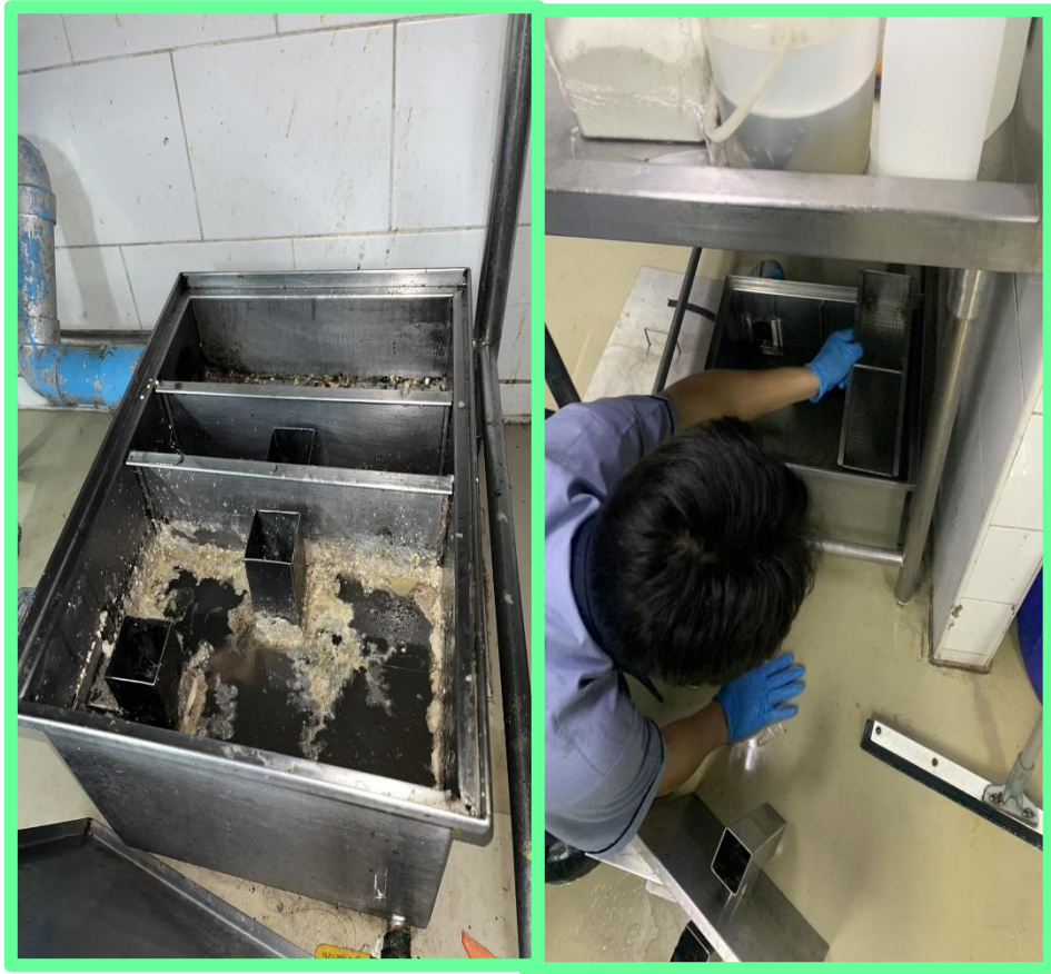
รูปที่ 12.17 ทางโครงการดำเนินการตักไขมันออกจากถังตกไขมันสัปดาห์ละ 1 ครั้ง
