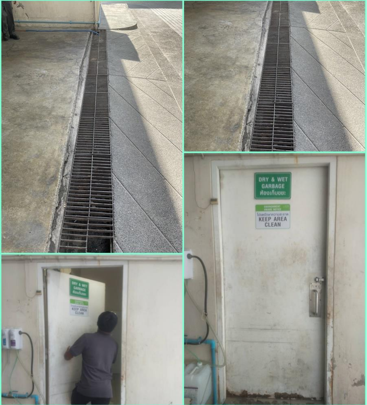
รูปที่ 12.21 ห้องพักมูลฝอยรวมมีช่องระบายน้ำทิ้งลงท่อรวมน้ำทิ้งเพื่อเข้าสู่ระบบบำบัดน้ำเสียของโครงการ
