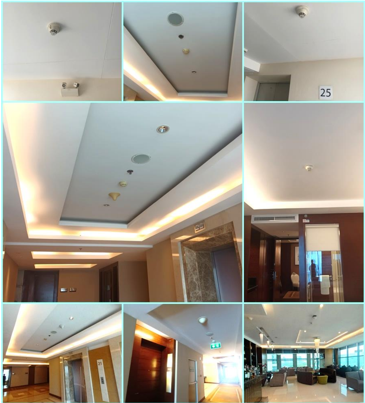
รูปที่ 12.36 เครื่องเครื่องตรวจจับความร้อน ของโครงการ
